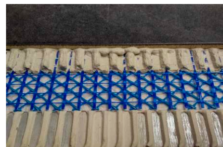
Ukážka aplikácie spevňujúcej rohože UNIVENTA DILATON pri aplikácii na podkladový betón s trhlinami
