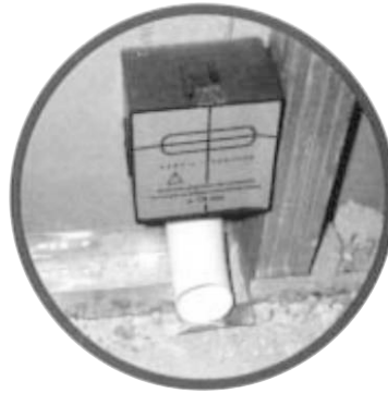
Montáž do sadrokartónovej konštrukcie.
