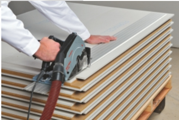
1. Odrezanie polodrážok na prvých doskách umiestnených ku stene.
