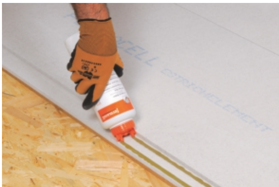
3. Nanesenie lepidla na polodrážku.
