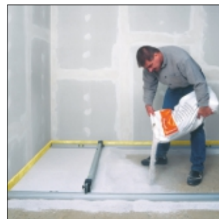
3. Vyrovnávanie podsypu
