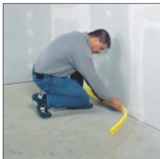
1. Upevnenie okrajového dilatačného pásu
