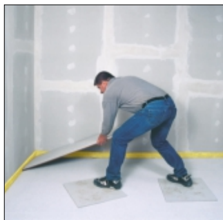
4. Pokladanie podlahových dosiek FERMACELL (ochrana proti pošlapaniu pomocou dvoch dosiek)
