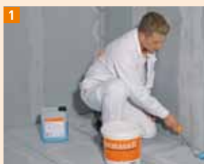
1 Základní nátěr FERMACELL naneste nejprve na přilehlou stěnu...
