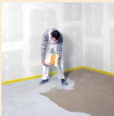
Použití voštinového zásypu FERMACELL
