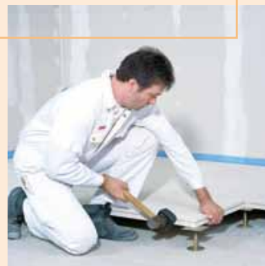
Spasování dutých podlahových prvků FERMACELL
