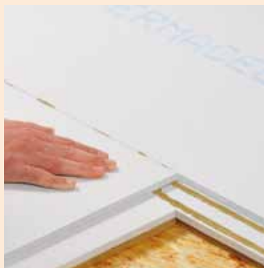
Slepení podlahových prvků
