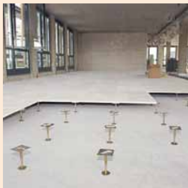
Suchá dutá podlaha s nosnými stojkami FERMACELL
