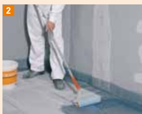
2 ... a pomocí válečku potom také na podlahu
