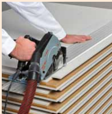
Odříznutí přesahující polodrážky pro první řadu podlahových prvků
