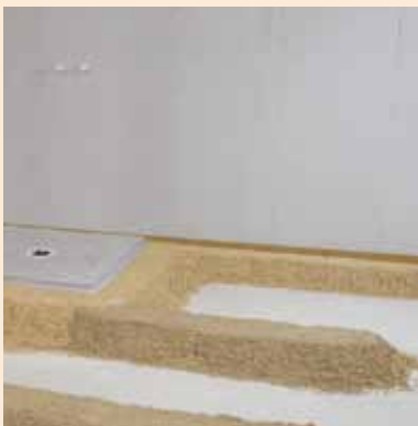
Čekání na zavadnutí násypů (cca. 20 minut)
