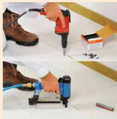
Upevnění pomocí šroubů nebo speciálních rozpěrných sponek
