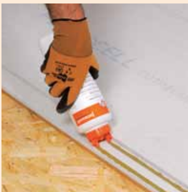
Nanášení podlahového lepidla FERMACELL na polodrážky
