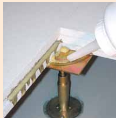
Podlahové lepidlo FERMACELL se nanáší na čtvercovou patku stojky
