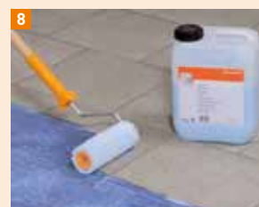
8 Po dosažení pochůznosti je celoplošně nanášena vhodná systémová penetrace.
