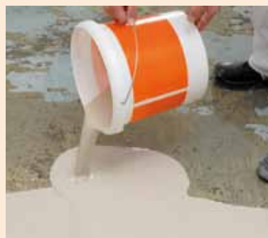
Nivelační hmotu vylijte a vyrovnávejte
