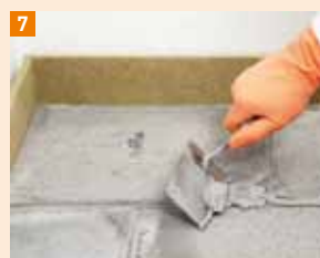
7 Přebytečné lepidlo je lžící setřeno a znovu použito
