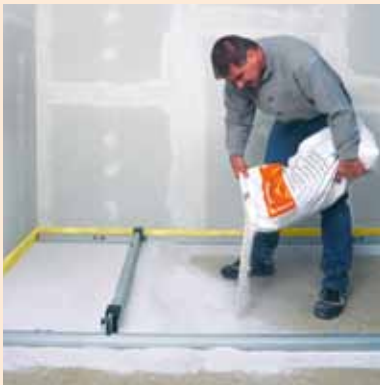
Použití vyrovnávacího podsypu FERMACELL
