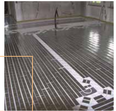
Příklad 1: Sádrovláknité podlahové prvky FERMACELL 2 E 22 nebo prvky Powerpanel TE na systémech teplovodního podlahového vytápění
