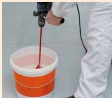
Promíchání vhodným míchadlem při nízkých otáčkách až vznikne homogenní, bezhrudková samonivelační hmota
