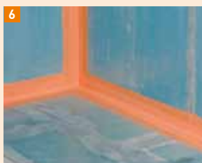
6 Při použití desek Powerpanel TE v oblasti A 2: Těsnící systém FERMACELL pouze v rozích
