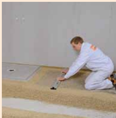
Nасыпанá hmota se v prostoru mezi násypy rovně stáhne
