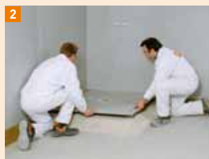
2 Varianta 1a: ve výši horní hrany korpusu odtoku je celá plocha pokryta rychlotuhnoucím podsypanem a poté usazen sprchový prvek
