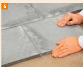
6 Prvky jsou přisunuty těsně k sobě (tloušťka spáry 1-1,5 mm)
