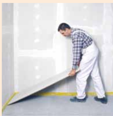
Pokládání podlahových prvků FERMACELL
