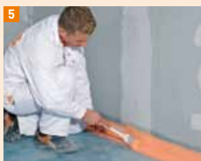
5 Těsnící pás přetřete ihned po přitlačení tekutou fólií FERMACELL
