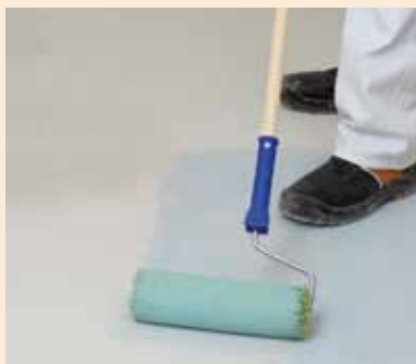
Příprava: penetrace podlahy
