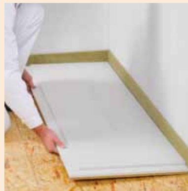
Pokládání podlahového prvku FERMACELL
