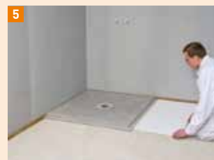
5 Varianta 1b: aby byla dosažena výška stupňovité drážky sprchového prvku, je po ploše umístěna izolace (EPS DEO 150) ve vrstvě 10 mm
