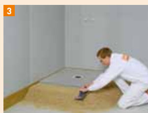
3 Varianta 1b: kolem sprchového prvku je ve výši přesahujícího stupně nasypána cca 200 mm široká hráz jako základ pro stažení zbývajících ploch
