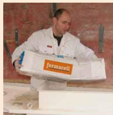
Míchání v míchačce na beton
