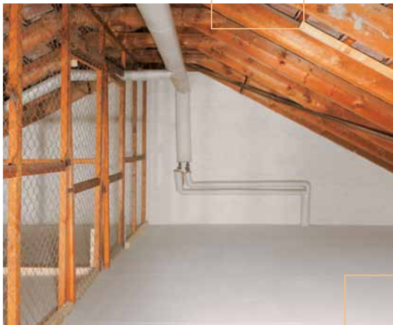
Spojení na péro a drážku: rychlá pokládka bez tepelných mostů
