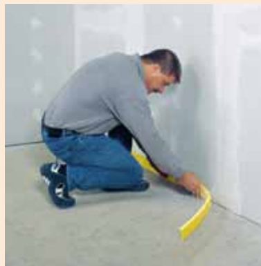
Upevnění krajních izolačních pásek
