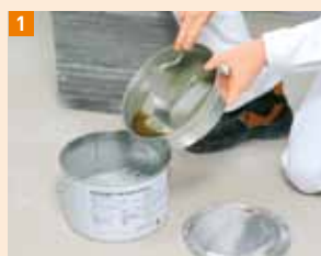
1 Obě složky lepidla jsou smíchány...
