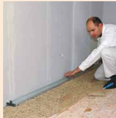
Položí se a vyrovná se první vrstva podsypu
