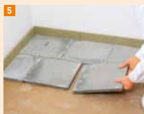
5 Podlahové prvky Powerpanel SE jsou pokládány s přesahem spár, takže v podstatě nevzniká žádný prorez
