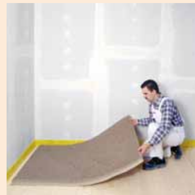
Pokládání podlahové voštiny FERMACELL
