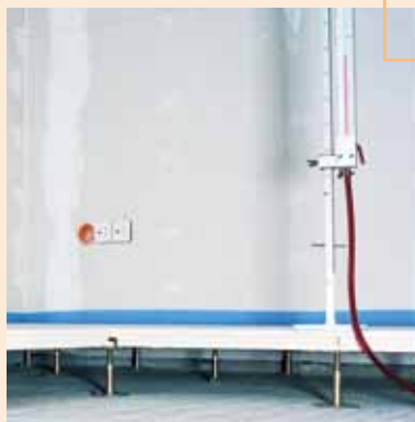
Vyrovnání podlahových prvků pomocí hadicové vodováhy
