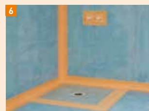
6 Po položení, slepení a sešroubování podlahových prvků Powerpanel TE jsou plochy natřeny základním nátěrem FERMACELL a v oblastech napojení umístěn těsnicí systém
