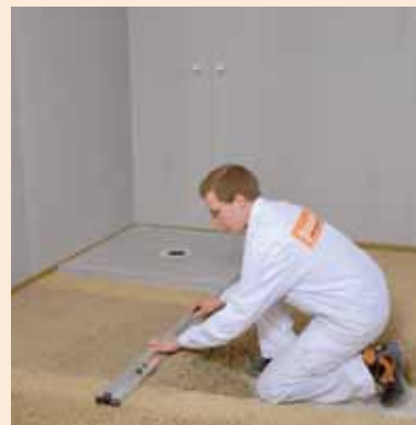
Položí se a vyrovná se první vrstva podsypu
